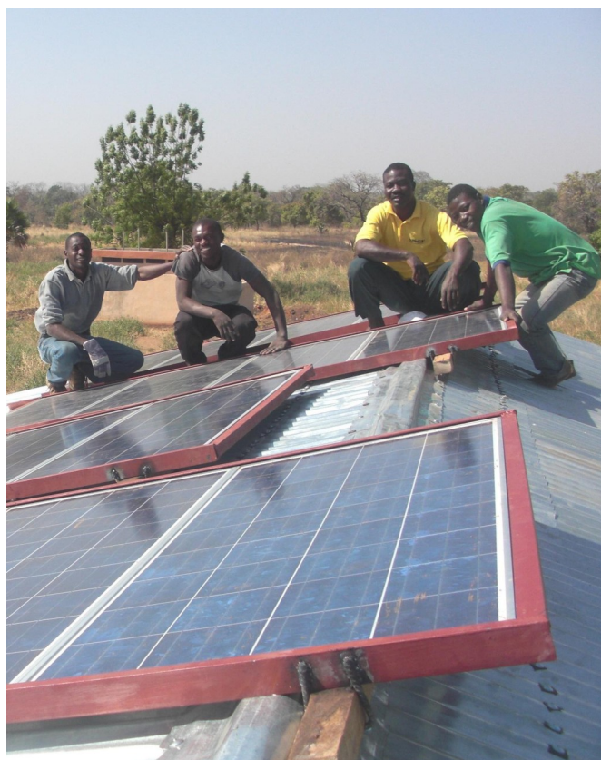
Nos amis électriciens burkinabé et togolais sur le toit de l'hôpital de Borgou
